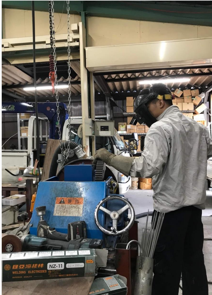
工場での加工 Gia công tại xưởng
